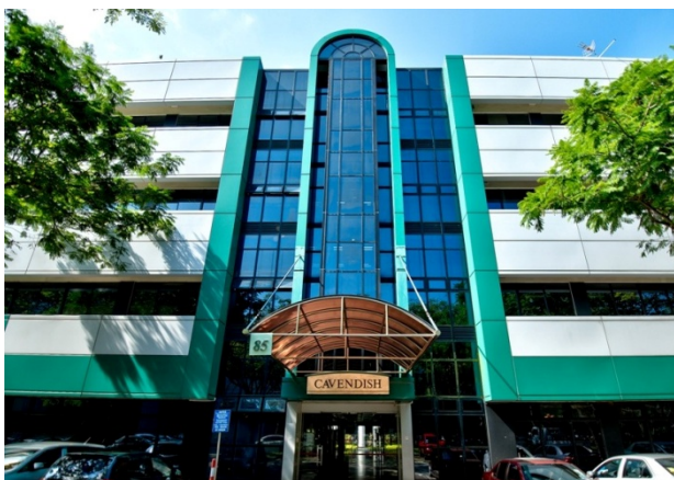
田中贵金属（新加坡）所进驻的科学园区大楼
